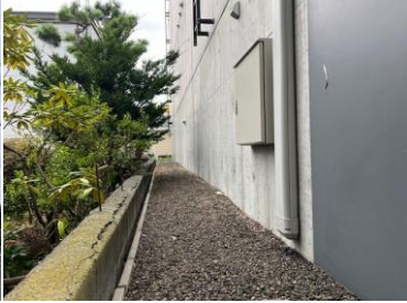
No2 外観敷地内
