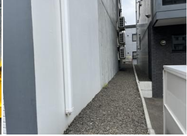
No6 外観敷地内
